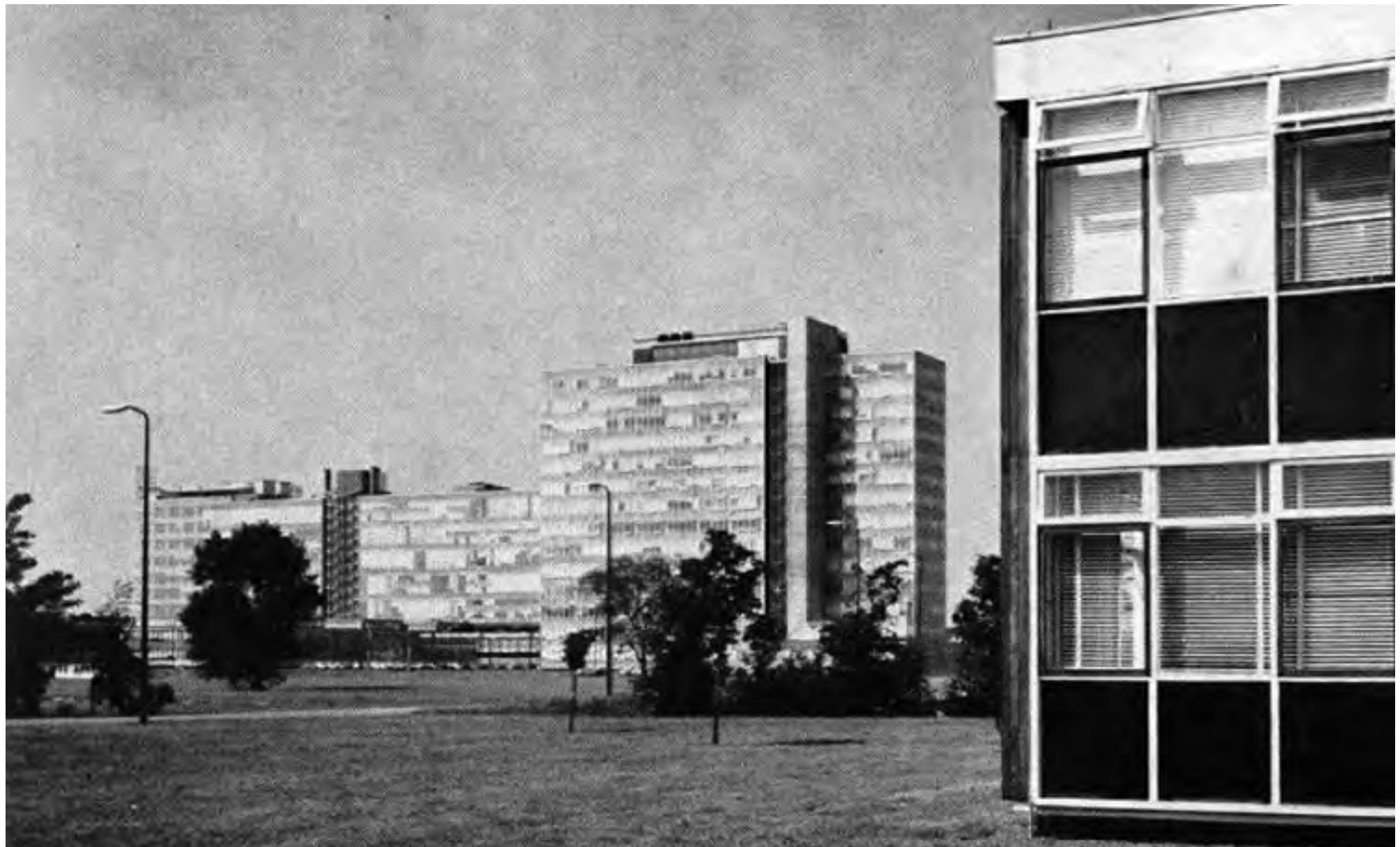
Afb. 2.5 - Terrein voor aanbouw Laplace gebouw.
