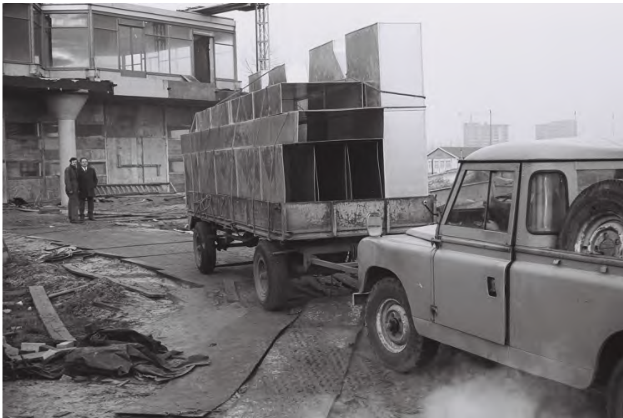
Afb. 2.1 - Het Laplace gebouw in aanbouw
