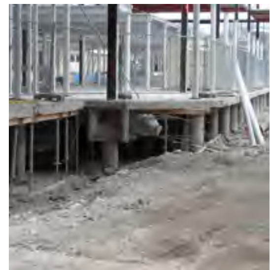
Afb. 3.4 Fundering van w-laag
