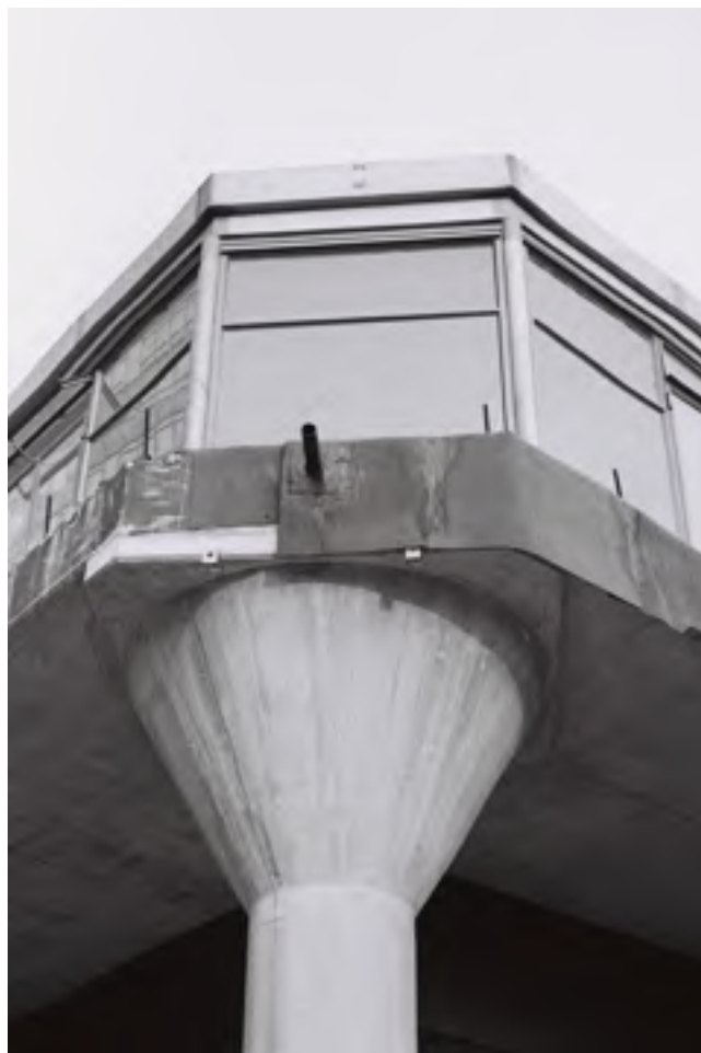
Afb. 3.52 - Bitumen op galerij
