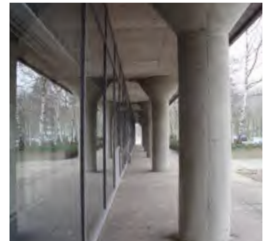
Afb. 13 Kolom in buitenste stramien
