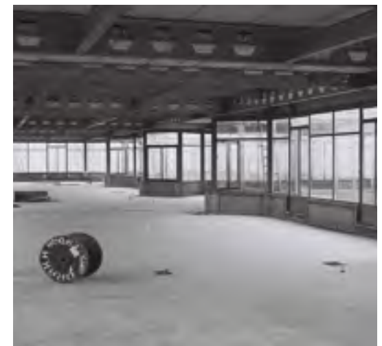
Afb. 3.7 Overzicht van de 1ste verdiepingvloer
