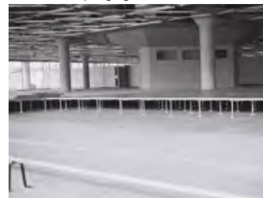
Afb. 3.10 computervloer in aanbouw
