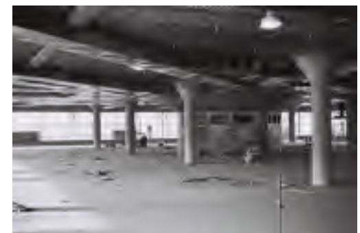
Afb. 3.28 Begane grond tijdens de uitvoering
