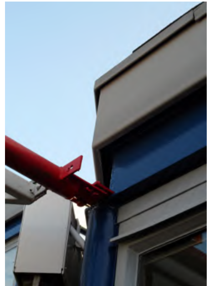
Afb. 3.43 - Koudebruggen wand dak aansluiting
