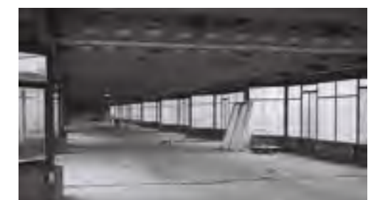
Afb. 3.29 1ste verdiepingsvloer tijdens de bouw
