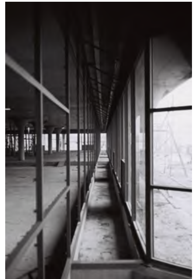
Afb. 3.53 - Vliesgevel met schoren
