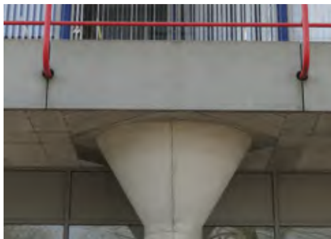
Afb. 3.45 -Koudebrug t.p.v. aansluiting kolom op vloer
