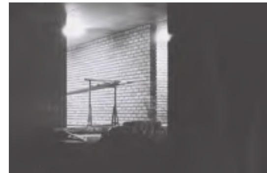
Afb. 3.55 Betonsteen metselwerk kelder
