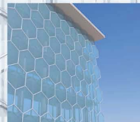
ONDERAANZICHT GELEEGDE MEMBRANEN
