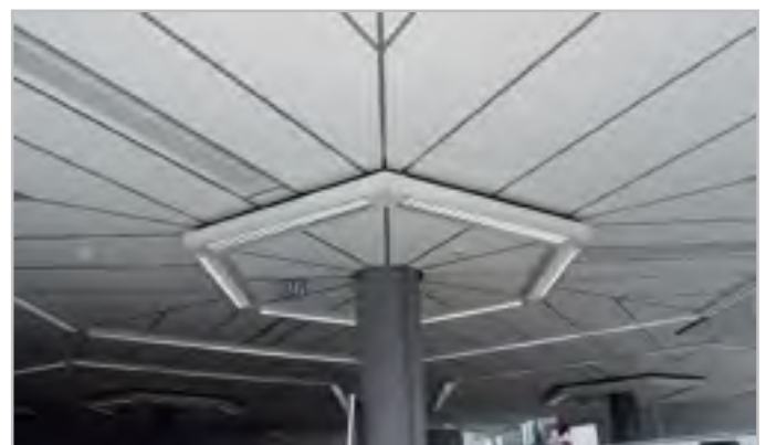
Fig. 4.14 Het nieuwe klimaatplafond met de inductie-units en de hergebruikte hoogfrequent verlichting
