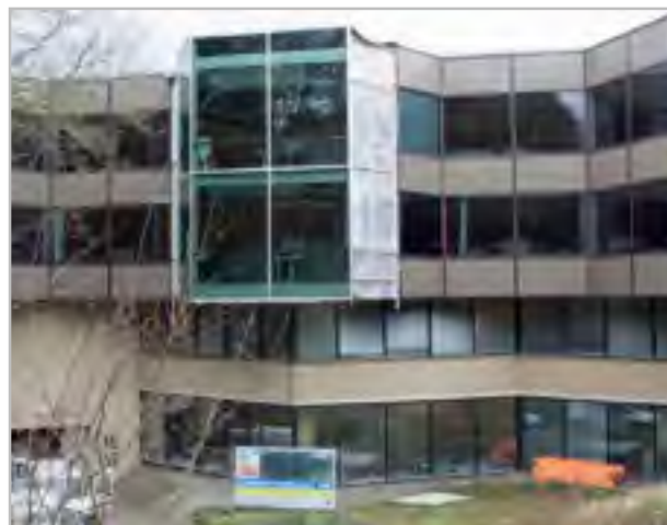
Fig. 4.11 Een proefgevel verschaft van te voren veel informatie over prestaties en werkwijze
