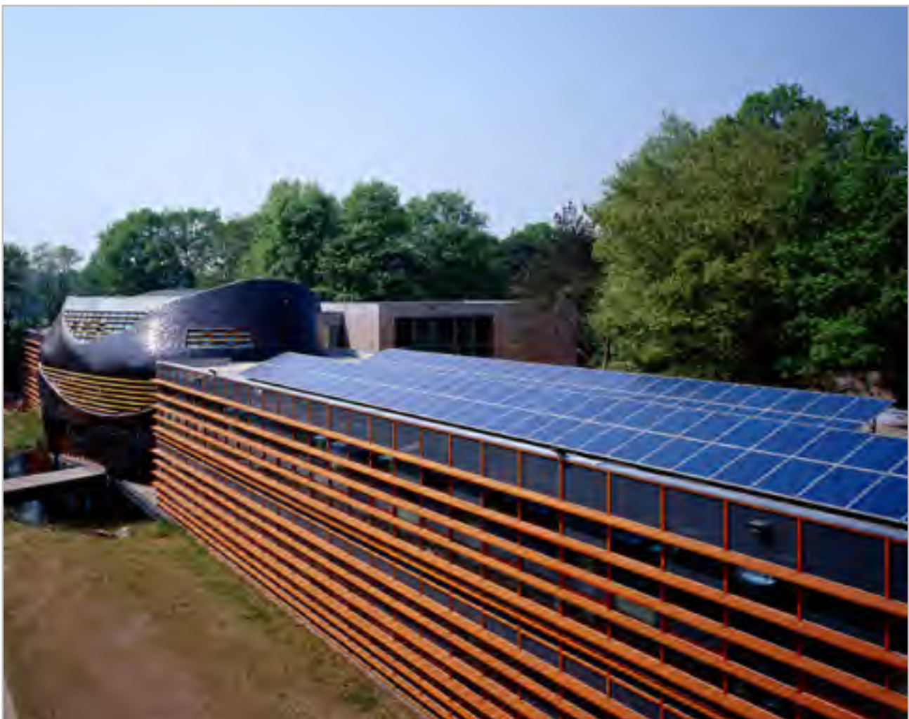
Fig. 5.12 De zonnepanelen op het dak
