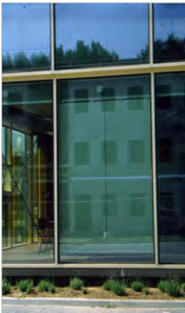
Fig. 2.13: Glazen gevel, 3-laags isolatieglas
