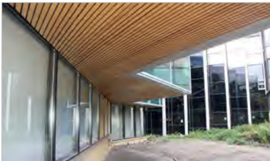
Fig. 4.17 De oude plafondlatten op de begane grond zijn opgeschuurd en behandeld en zowel binnen als buiten hergebruikt
