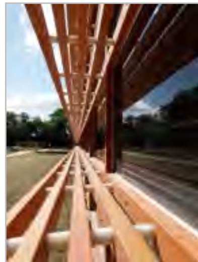
Fig. 5.8 De houten zonwering voorkomt oververhitting van het gebouw in de zomer, maar laat indirect daglicht naar binnen
