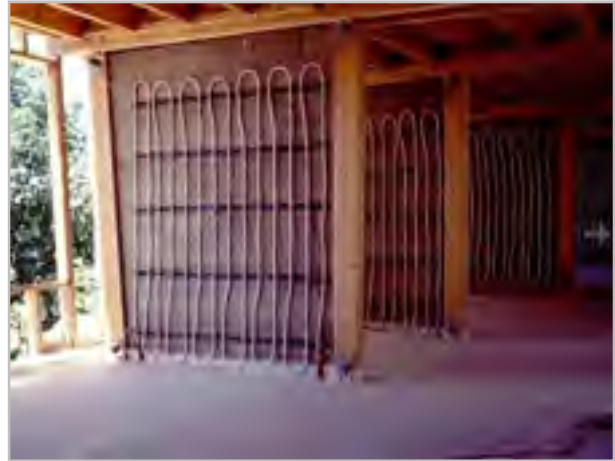
Fig. 3.8 Binnenwanden voorzien van wandverwarming, dit maakt overige warmte afgiftesystemen overbodig
