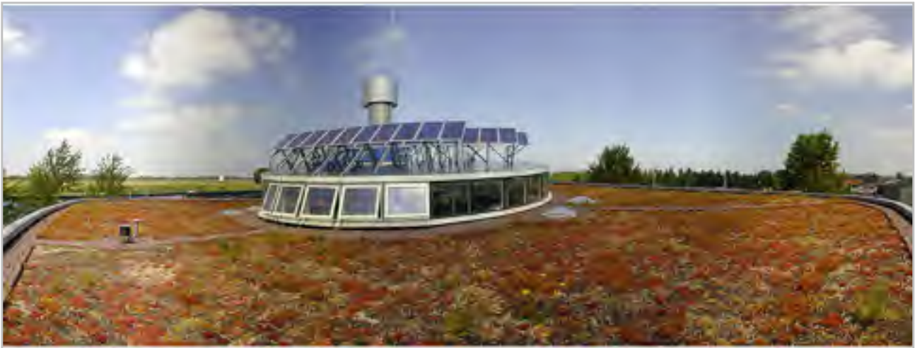
Fig. 3.20 Het mos-sedum dak dat als buffer dient voor de opvang van regenwater
