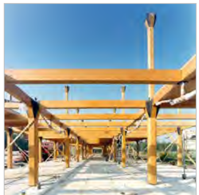
Fig. 2.14, 2.15, 2.16: Demontabele houten constructie
