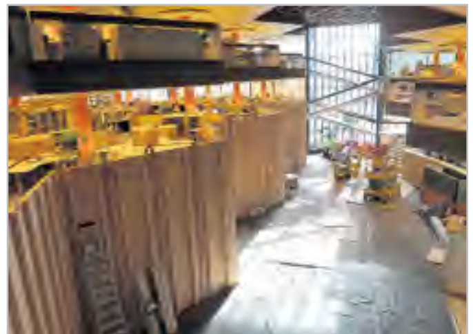
Fig. 4.10 De vide tijdens de verbouwing, links is het kantoor nog gewoon in gebruik
