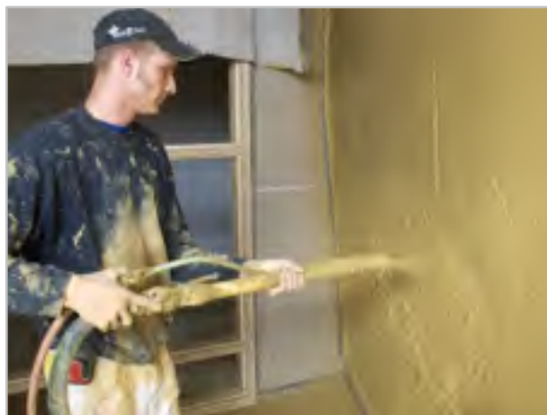
Fig. 5.14 Het leemstucwerk wordt aangebracht
