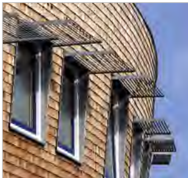
Fig. 3.18 Verzaagde meerpalen in een 2 e leven, gebruikt als gevelbekleding, de uitstekende zonnluifels beperken de interne zonneload
