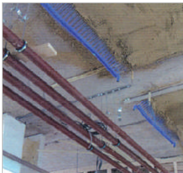
Fig. 5.11 Klimaatmatten onder het leemstucwerk.
