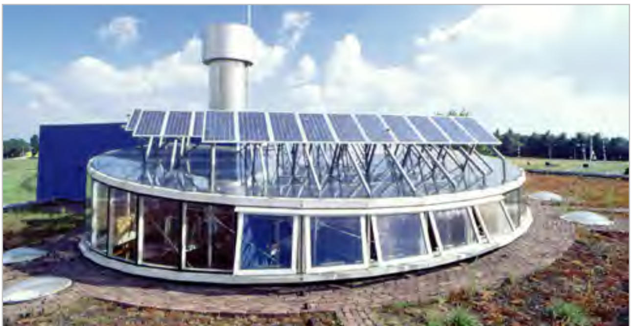
Fig. 3.15 PV-panelen op het dak die zorgen voor elektriciteitsopwekking en daarnaast dienen als buitenzonwering, de kiepramen zorgen voor spuiventilatie op zomerse dagen.
