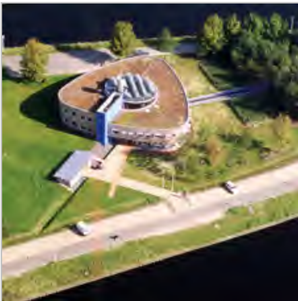
Fig. 3.21 Geheel rechts op de foto het rietveld verscholen in het groen, de greppel zorgt voor de toevoer van het (regen)water, linksonder een greppel dat dienst doet als waterbuffer. Verder is duidelijk te zien dat het overgrote deel rond het gebouw onverhard is waardoor het water snel de bodem kan infiltreren.
