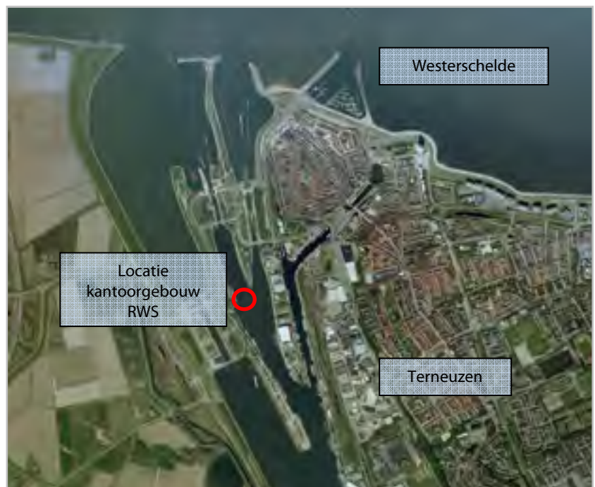
Fig. 3.3 Sluizencomplex bij Terneuzen (Zeeuws-Vlaanderen)
