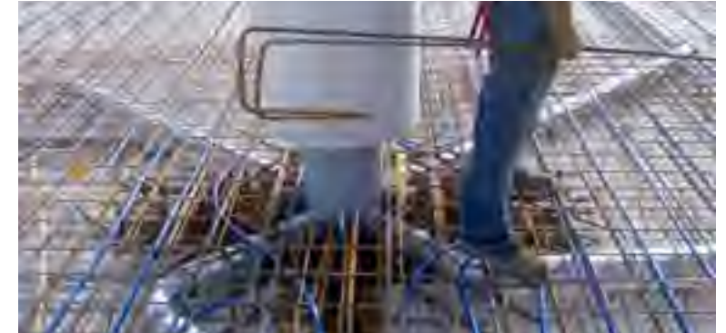
AFBEELDING 4: AANSLUITING MECH. VENTILATIE, VLOER EN KOLOM
